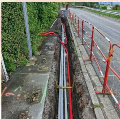
Travaux d'enfouissement des réseaux
